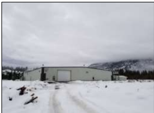
DMG マイニングファームの建屋外観 (カナダ国内)
